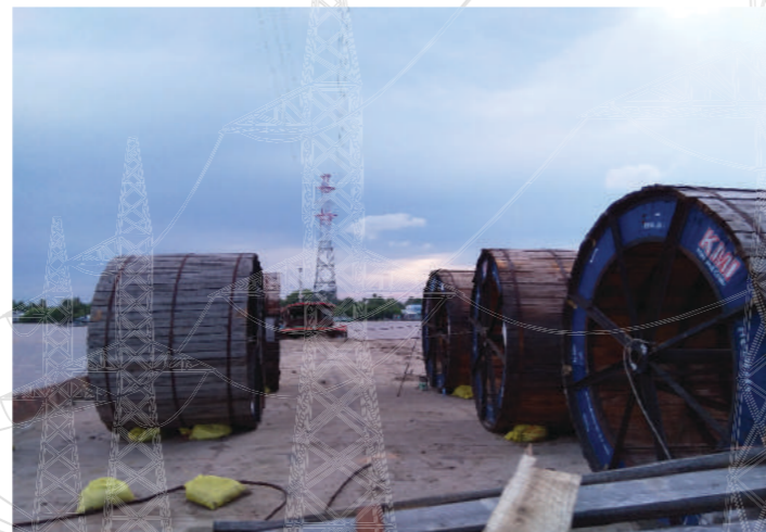
Thi công lắp đặt dây ACCC cho đường dây 220 KV Cao Lãnh – Thốt Nốt, đoạn vượt sông Hậu
